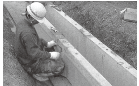
ボルト連結（作業中）
