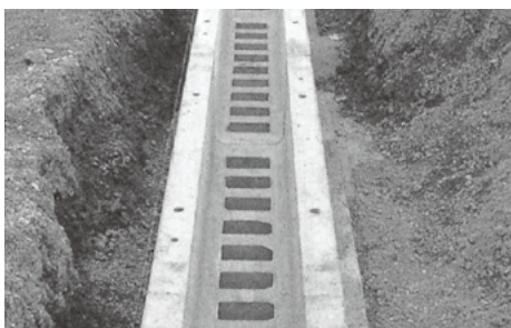
中詰め・調整コンクリート打設前
