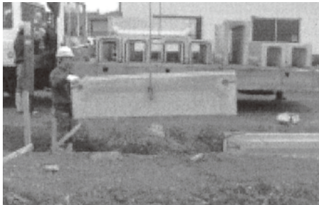
製品の吊り込み
