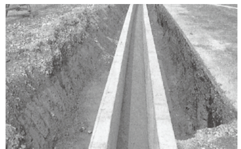
中詰め・調整コンクリート打設後
