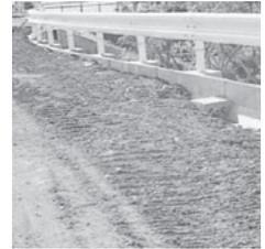
連結部 コンクリート打設後
