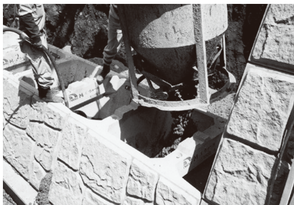
胴込めコンクリートの打設
