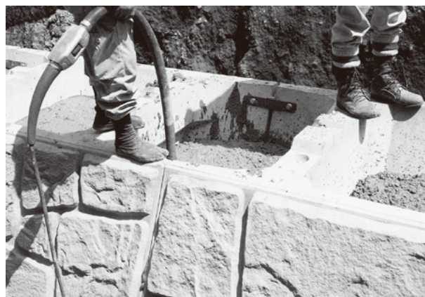
胴込めコンクリートの締固め
