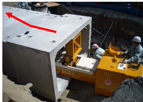
斜型製品の据え付け状況
