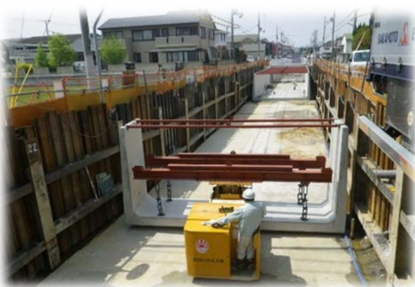
U型製品への適用例 (水路) 内幅 4700 × 内高 2400mm
