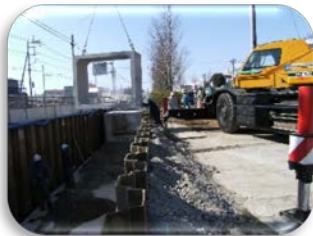
据え付け状況
