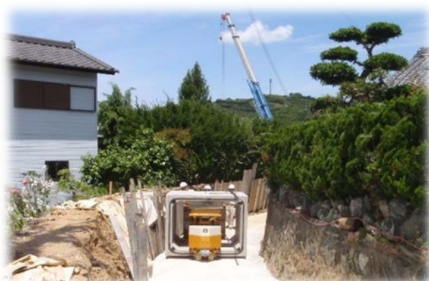
住宅密集地への適用例 (水路) 内幅1600×1300
