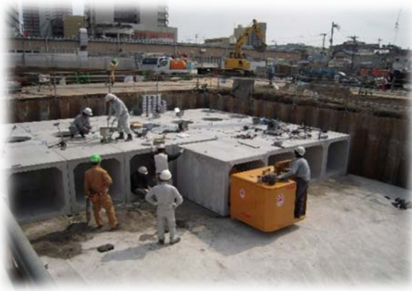
BOX型雨水貯溜槽への適用例 内幅1200×内高1200mm (ボックスどうしは耐震接続「TB(タッチボンド)工法」)
