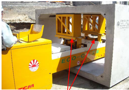
リフトアップ部
