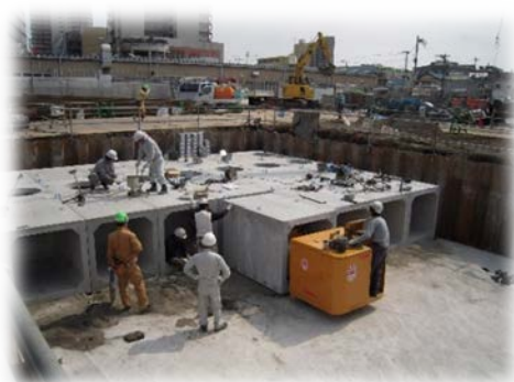
BOX型雨水貯溜槽への適用例 内幅1200×内高1200mm (ボックスどうしは耐震接続「TB(タッチボンド)工法」)
