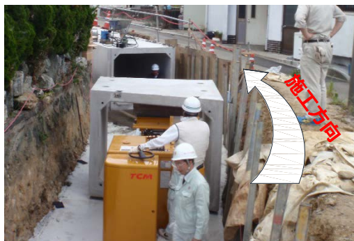
急曲線での施工状況
