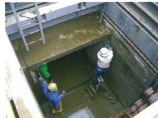
▲函体縦締用PC鋼棒緊結状況
