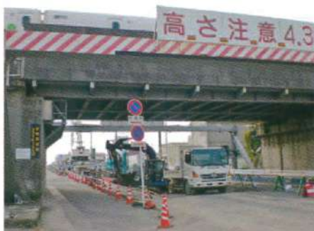
▲施工全景 (JR高架下施工状況)
