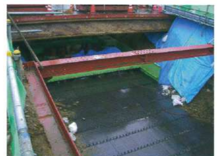
▲FCプレート設置状況
