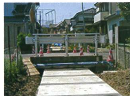
▲既設橋梁下横断
