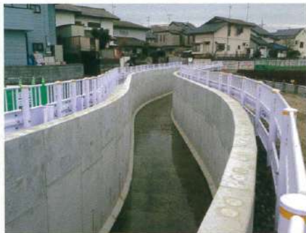
▲施工後（急曲線部 R=20m、30m）
