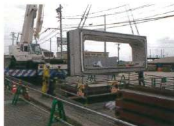
▲施工状況 (発進部より函体据付・推進)
