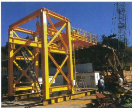
▲クレーンの進入ができない場所では、シールド機に函体吊り下ろし設備を載置
