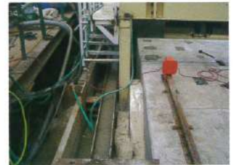
▲裏込注入状況
