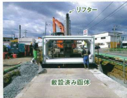
▲函体敷設状況
