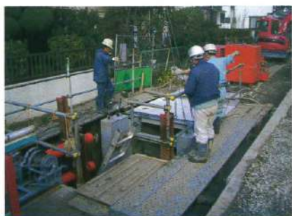
▲函体は発進立坑内に吊り下し、元押し設備で順次送り出します。
