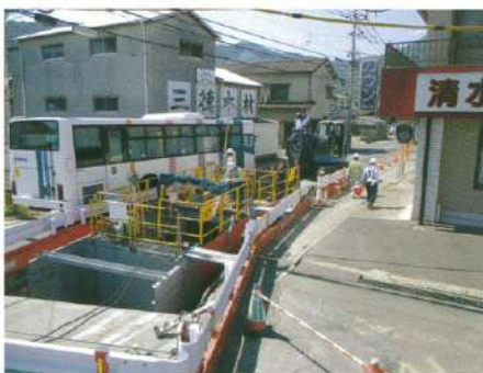
▲施工状況 (初期掘進)
