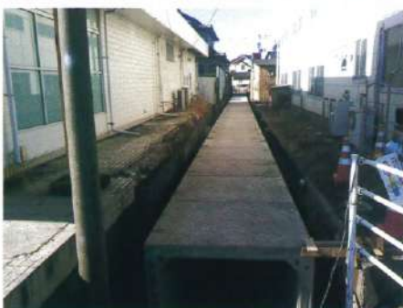
▲施工後（函体敷設完了）
