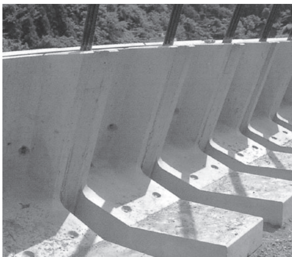
ブロック設置（背面）
