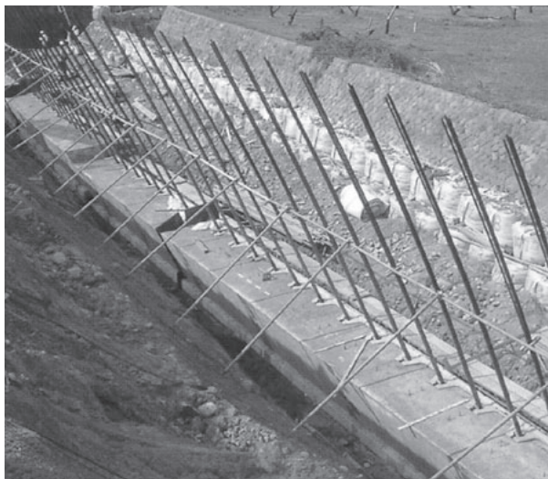
縦貫鉄筋設置
