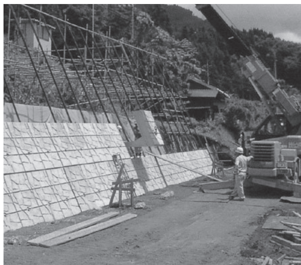
ブロック設置作業
