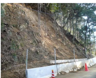
施工後：崩壊土砂を捕捉
