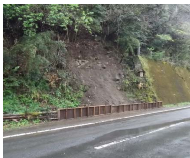
施工前：崩壊現場に仮設の木柵
