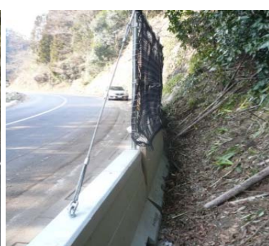
施工後：落石混じり土砂を捕捉
