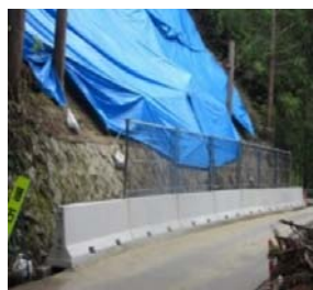
崩壊斜面下に仮設で設置
