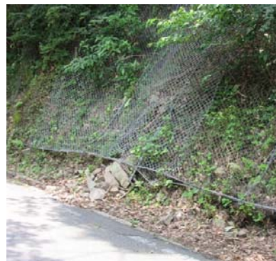
落石防護網裾のこぼれ出し状況
