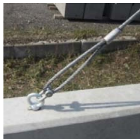
斜ロープと基礎擁壁を接続
