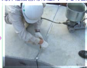
上部より頂版天端部へ注入
