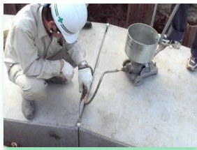
頂版から注入
