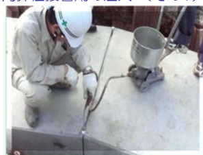
注入口より側壁部・底版部へ注入
