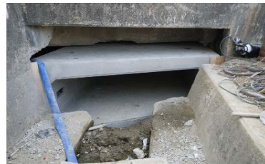
横引き完了直後（隙間は充填）
