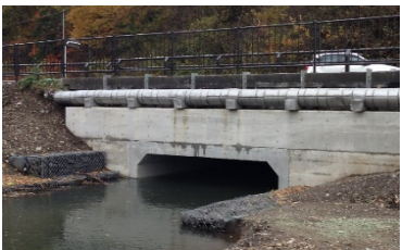
長寿命化（補強後）
