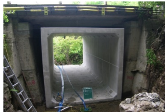
横引き完了直後（隙間は充填）
