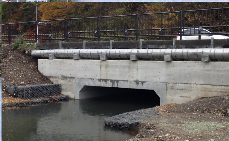
長寿命化（補強後）
