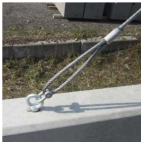
斜ロープと基礎擁壁を接続
