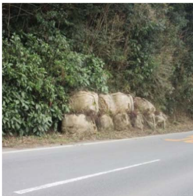
施工前：大型土のう
