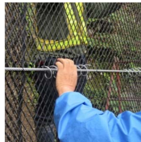
ネットジョイント設置
