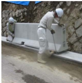
基礎擁壁の設置状況
