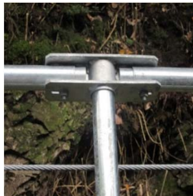
トッパーにCSソケットが挿入されている状況
