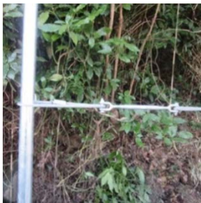
横ロープとPSターンバックルの接続
