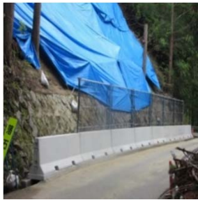
崩壊斜面下に仮設で設置
