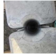
設置後に上から見た状態
