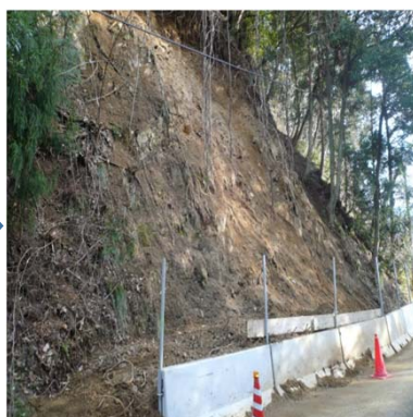
施工後：崩壊土砂を捕捉
