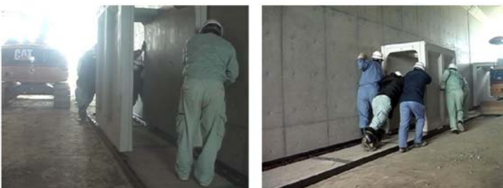
三重県 自由勾配側溝 B700×H1600×L2000 W=1,790kg 人力・機械併用施工
