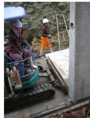
岐阜県 L型擁壁 H4000×B2650×L2000 W=7,200kg (縦断勾配10.9%)
