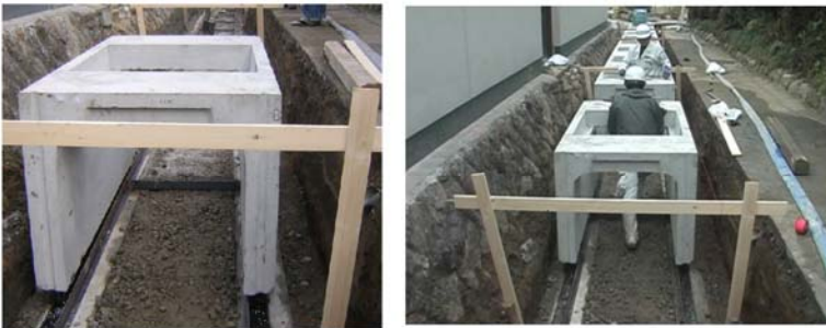
三重県 自由勾配側溝 B800×H700×L2000 W=1,270kg 人力施工
