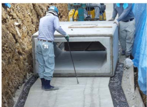
三重県 ボックスカルバート B1400×H600×L2000 W=3,950kg 人力・機械併用施工
