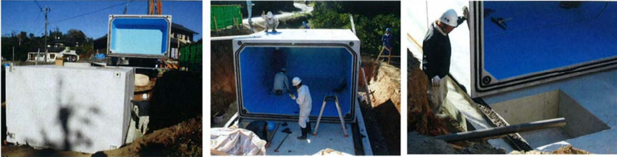
大分県 耐震性防火水槽40m 3 4ピース maxB3200×H2000×L1600 W=10,830kg
